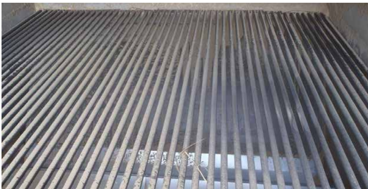
Overdækning på korngrav – tre-fire cm mellem rør, så man ikke kan få en fod igennem.
