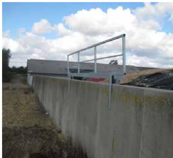
Flytbart rækværk med hjul, der let køre hen ad siloens kant i takt med, at siloen tømmes. Rækværk flyttes let med pallegaffler til anden silo.
