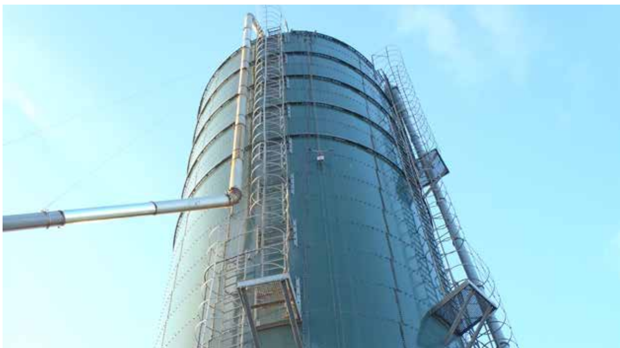
Gastæt silo monteret med stiger og rygbøjler. Bemærk platformene for hver 6-8 meter.
