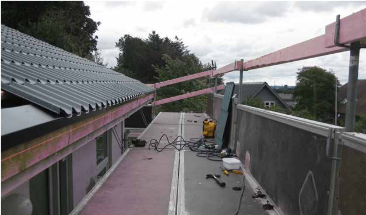
Stillads med skærm og rækværk.
